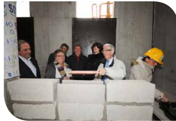
Paris 18 ème - Centre social Goutte d'Or - Pose de la première pierre
