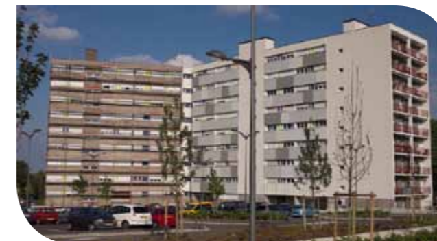
Longwy - Travaux de réhabilitation dans le quartier «Les Jardins de Vauban»
