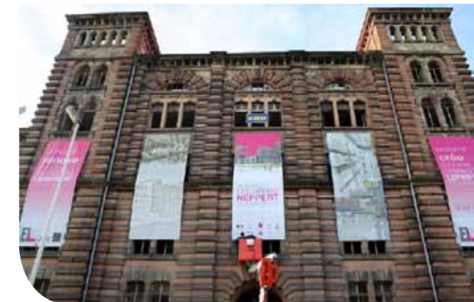
Mulhouse - Lancement des travaux de la Caserne Lefebvre
