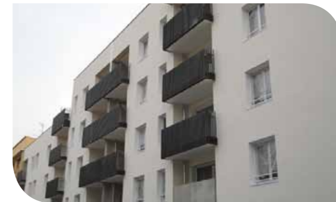
Villeurbanne (69) - Rue Cambon
