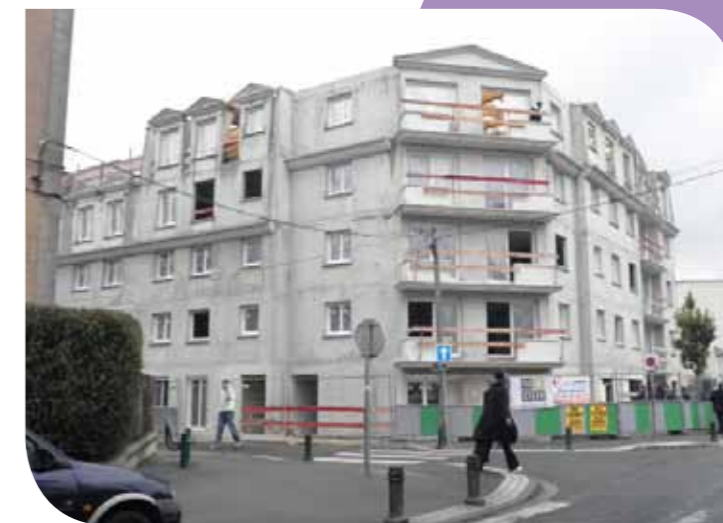
Pontault-Combault - 36 logements en chantier
