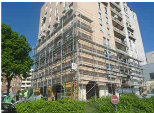
Les travaux de réhabilitation énergétique, qui ont débuté en avril, portent sur l'intérieur et l'extérieur des résidences Batigère.
