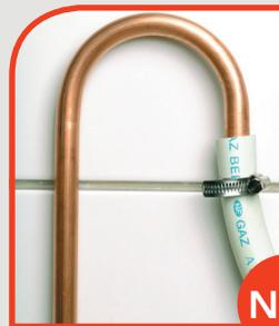
Tube caoutchouc monté sur un tube cuivre sans embout.
