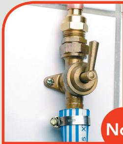
Flexible Vissogaz coupé et monté sur l'embout d'un robinet non normalisé.
