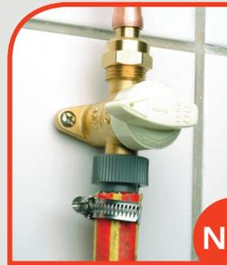
Tuyau et raccord d'arrosage montés sur un robinet à pas de vis.
