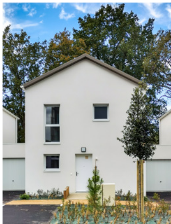
Saint-Vincent de Tyrosse (40) 10 logements
