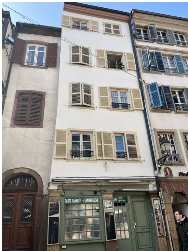
Strasbourg (67) - place du Marché au Cochon de Lait - 4 logements
