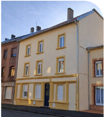
NILVANGE (57) 38 rue Joffre Après travaux de modernisation
