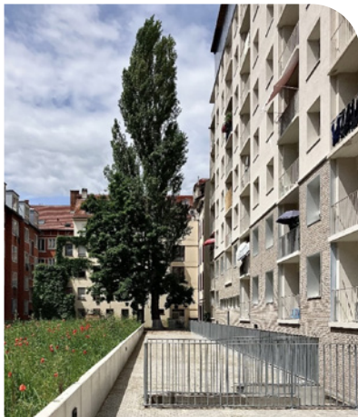
Rénovation Thermique de 95 logements Strasbourg - LDA Architectes
