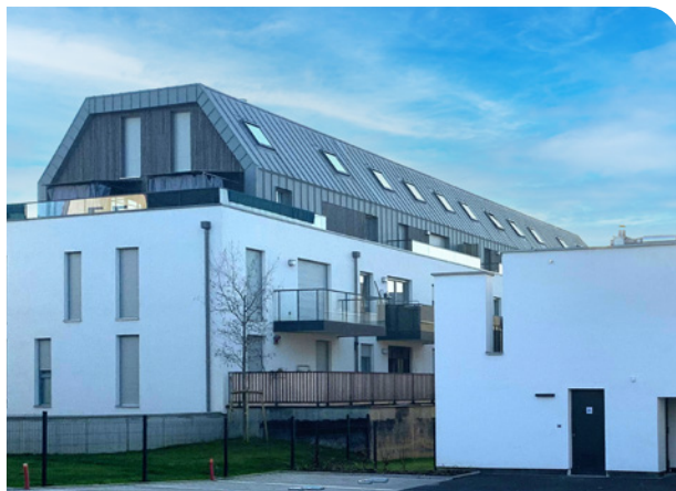
Construction de 18 logements sociaux – Souffelweyersheim Antonelli & Herry Architectes
