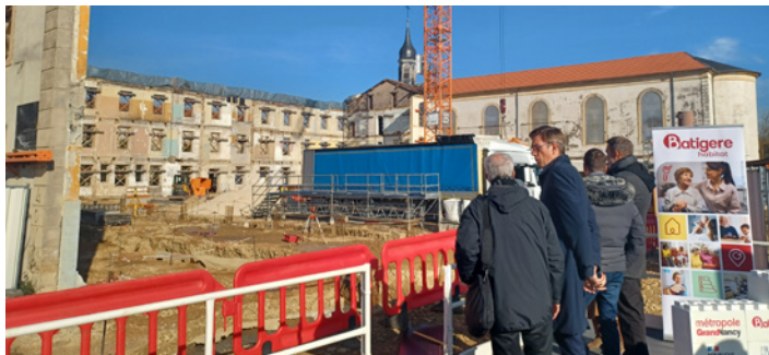
Suivi des clauses d'Insertion par l'Activité Économique sur le site de Villemin-Maringer à Nancy (54) en réhabilitation
