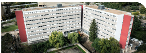
Livraison de la réhabilitation du site de Metz Blida (57)
